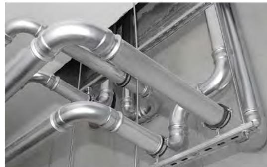
Cijevi i fitinzi su osigurani protiv korozije slojem galvaniziranog cinka (Fe/Zn 88) debljine 8-15  $\mu\text{m}$ , nanesenim na vanjsku površinu elemenata.
